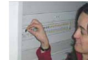
Alle Fehlerstromschutzschalter sind mit einer Prüftaste zum Funktionstest ausgestattet. Wird die Prüfung nicht durchgeführt, können die Kontakte verkleben. Ein Auslösen im Fehlerfall ist dann nicht möglich.
